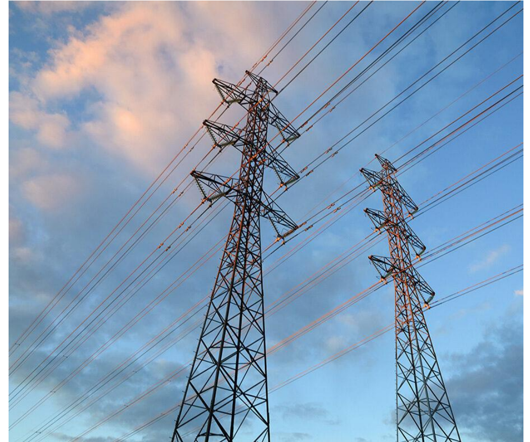
Kuvituskuva sähkölinjoista. Granlund Oy.
